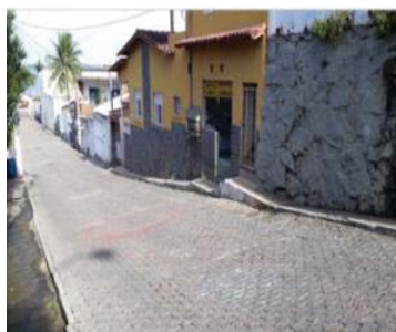
Falta de nivelamento entre as calçadas
