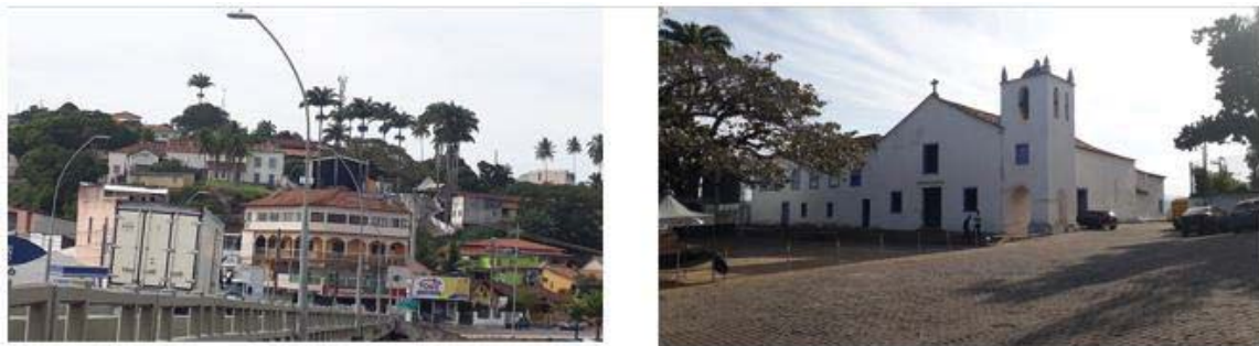
Figura 1. Vistas do Santuário de Anchieta – ES. Lado esquerdo é a vista do Santuário visto da ponte. A figura do lado direito é a vista frontal.
